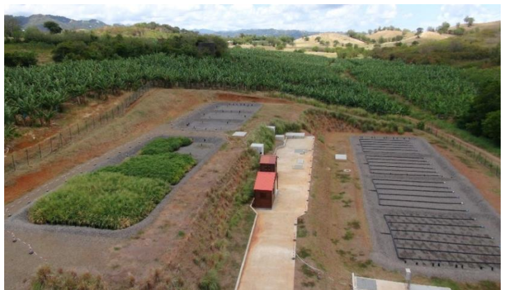
Figure 2 : STEU de Mansarde Rancée au Robert -- photo aérienne
